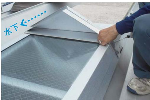
先に合わせた高さを目安に、水上末端のポリカ支持フレームは、ガラス押えの水上末端に合わせ取り付ける。ポリカ支持フレーム上側のφ7mmの穴にノンヘッドビス(5×16)で取り付ける。片側を仮止めし、もう片側を止めると作業しやすくなる。
