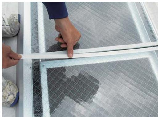
ガラスの継ぎ目に、同梱の**シーリング材**(ポリカーボネート樹脂用)を打つ。シーリング材を打った後、シーリングヘラで均す。
