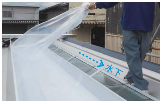
ポリカプレートをポリカ支持フレームに載せた後に、外面のマスキングフィルムを剥がす。
