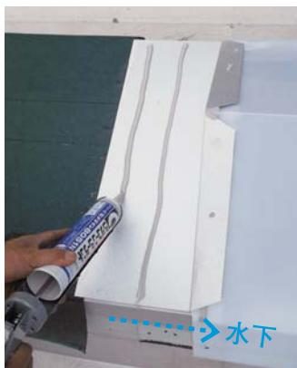
水上面戸の上に雨カバーをかぶせる。雨カバーを板金金具にビス止めする。★雨カバーは別途調達品
